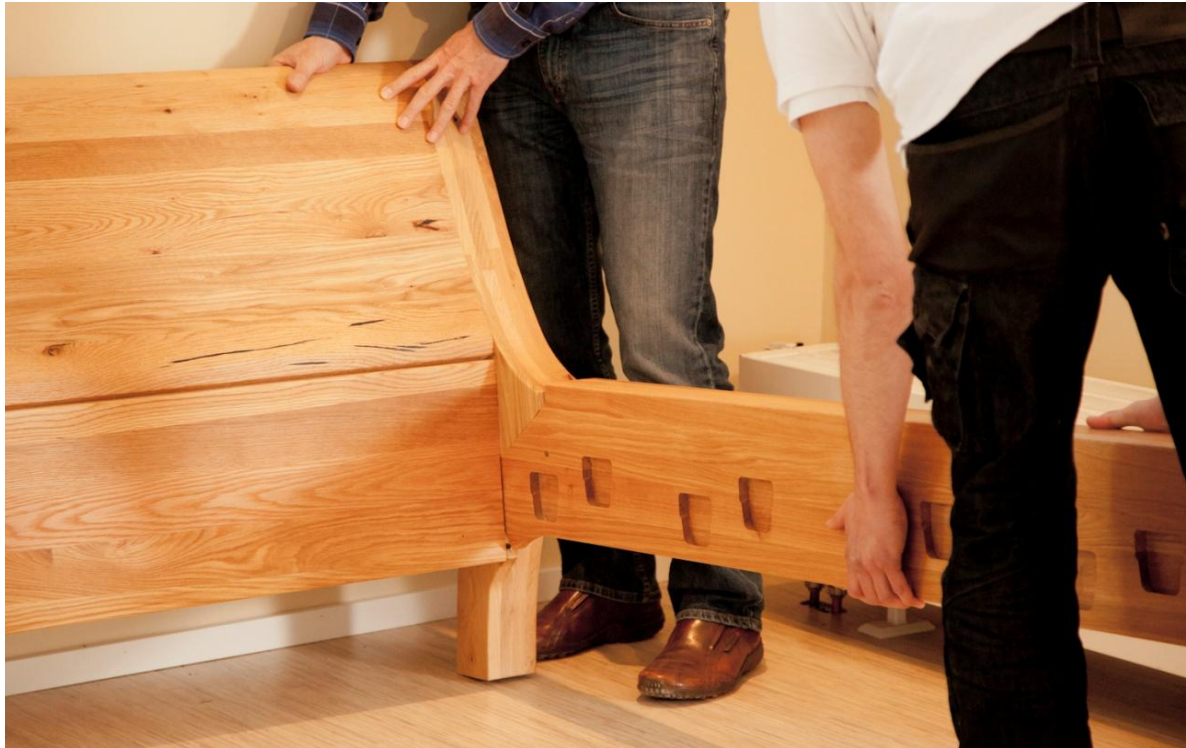
Abb. 1) Seitenteil in Kopfteil einfädeln.
